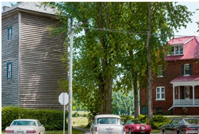
À gauche, le bâtiment abritant le réservoir d'eau du village
