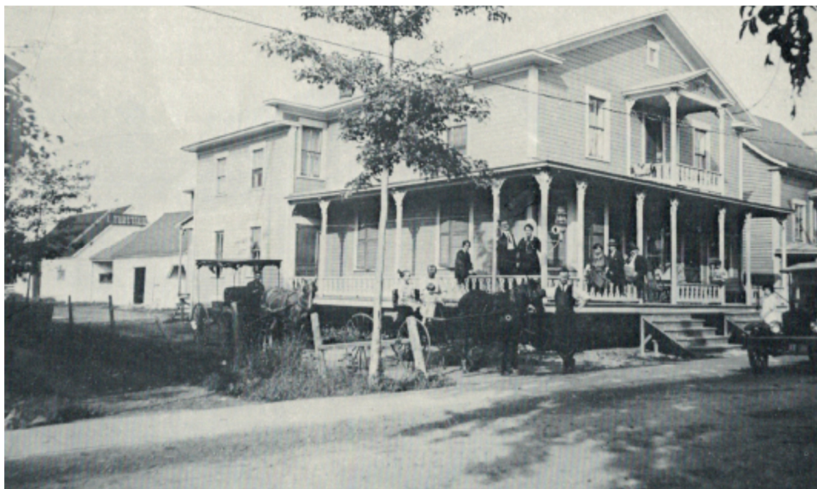
Magasin général de Ludger Trottier à Gentilly, 1913. Photo: auteur inconnu. Archives de Patrimoine Bécancour.
